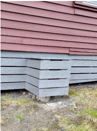
Bilde til venstre: Utvendig fundamentering ved rehabilitering av brakke 9 i Nybyen. Bilde til høyre: Støttebjelke ved refundamentering ved rehabilitering av brakke 9 i Nybyen. Foto: Riksrevisjonen 2021
