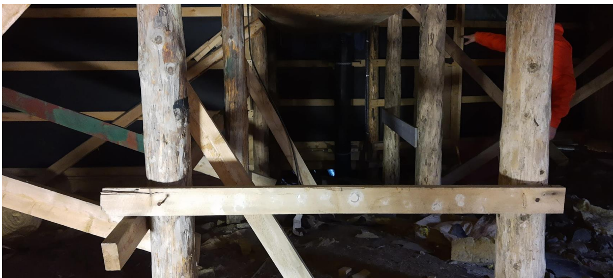
Fundamentering av en av brakkene i Nybyen. Foto: Riksrevisjonen 2021.
