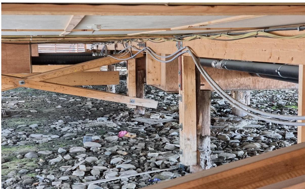
Eksempel på fundamenteringen til SNBs boliger på Elvesletta nord. Foto: Riksrevisjonen 2021.
