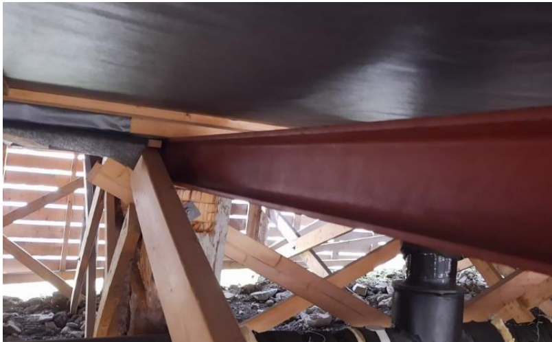
Bilde til venstre: Utvendig fundamentering ved rehabilitering av brakke 9 i Nybyen. Bilde til høyre: Støttebjelke ved refundamentering ved rehabilitering av brakke 9 i Nybyen. Foto: Riksrevisjonen 2021
