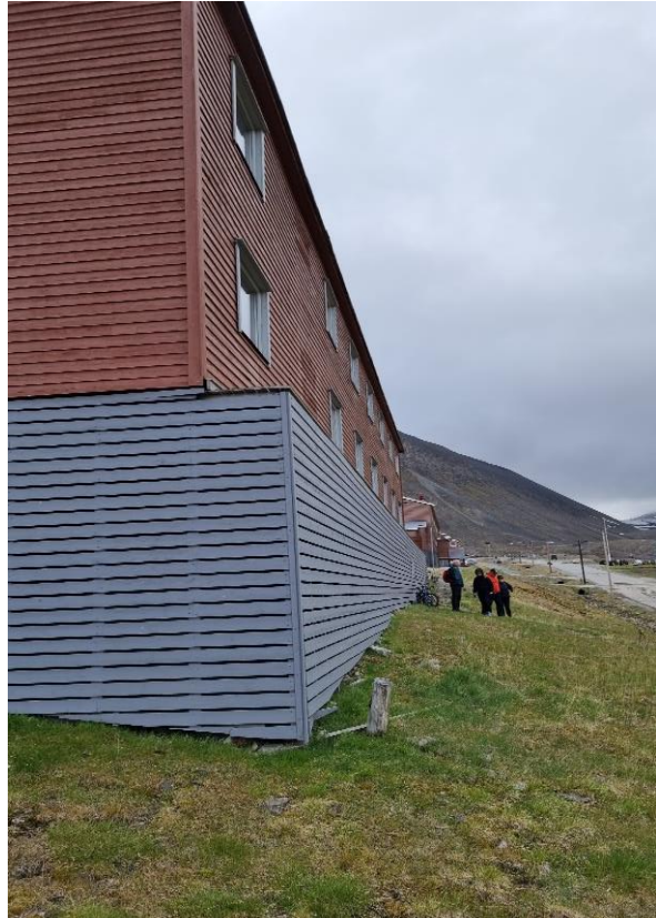
Bildet til venstre: Ny fundamentering ved rehabilitering av brakke 3 i Nybyen. Bildet til høyre: Innkledning av nye pæler på utsiden av bygningen ved rehabilitering av brakke 3 i Nybyen. Fotos: Riksrevisjonen 2021.
