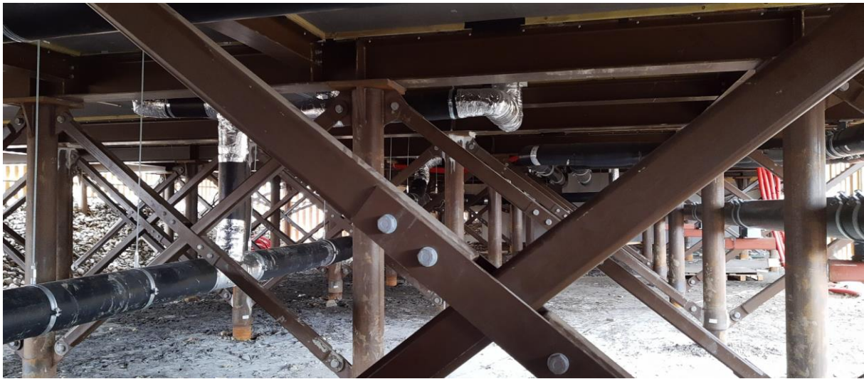
Fundamenteringen av de nye studentboligene på Elvesletta. Foto: Riksrevisjonen 2021.
