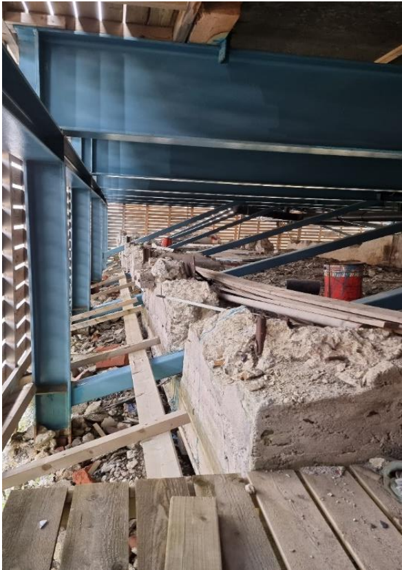
Bildet til venstre: Ny fundamentering ved rehabilitering av brakke 3 i Nybyen. Bildet til høyre: Innkledning av nye pæler på utsiden av bygningen ved rehabilitering av brakke 3 i Nybyen. Fotos: Riksrevisjonen 2021.
