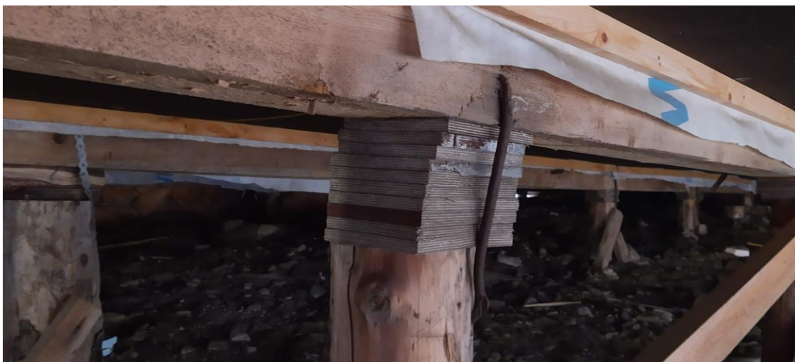
Plater satt inn over trepæl på en av brakkene i Nybyen. Foto: Riksrevisjonen 2021.
