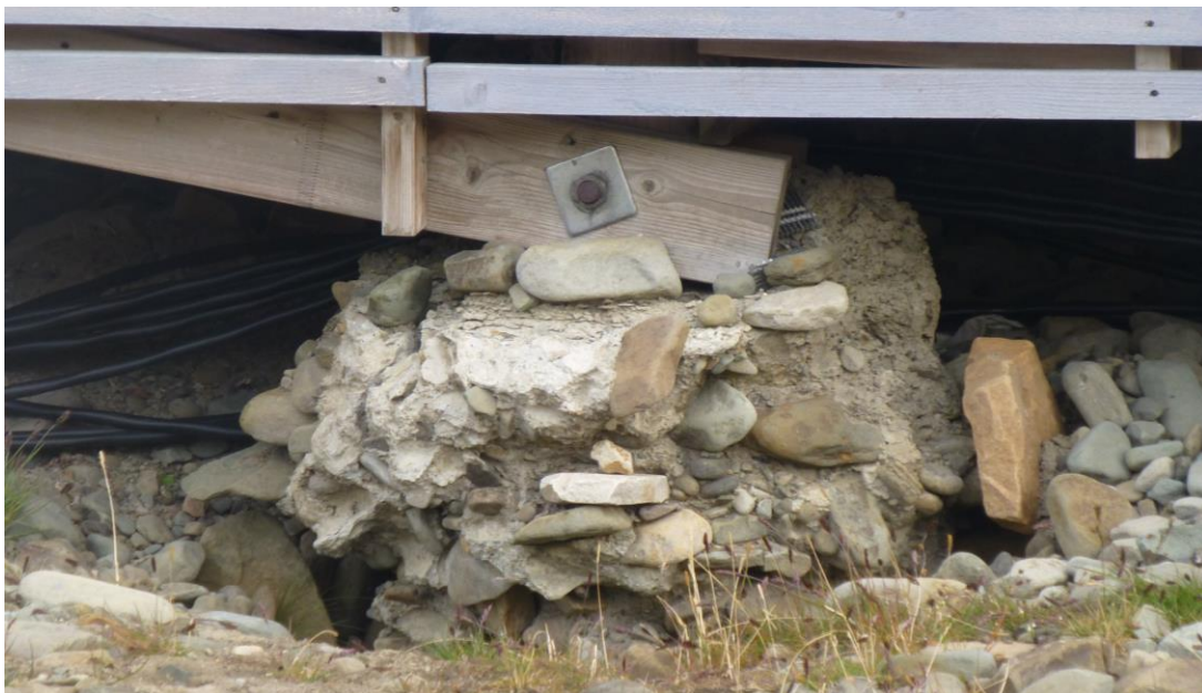
Eksempel på fundamenteringen av SNBs boliger på Elvesletta nord. Foto: Riksrevisjonen 2021.
