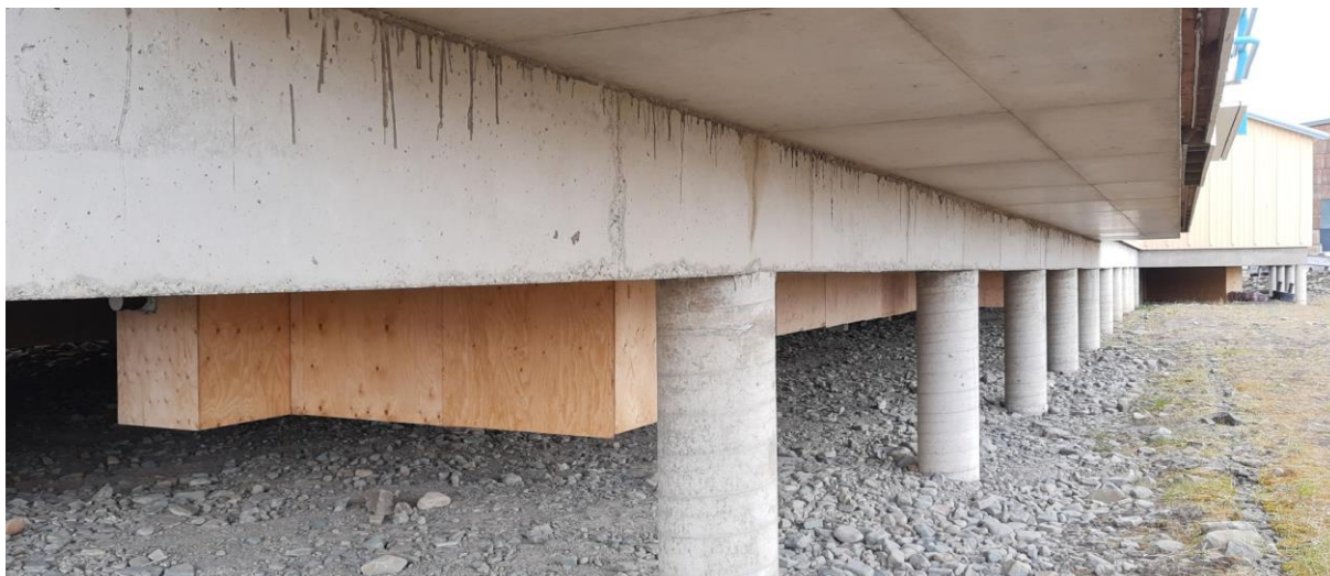
Fundamenteringen av Longyearbyen sykehus. Foto: Riksrevisjonen 2021.
