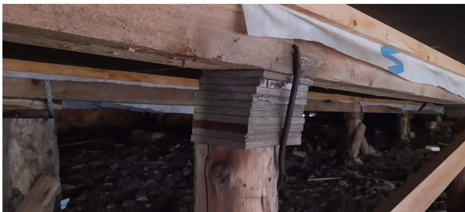
Plater satt inn over trepæl på en av samskipnadens brakker i Nybyen. Foto: Riksrevisjonen 2021.
